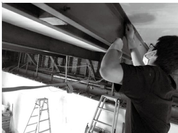
〔図表 13〕 天井の板貼り付けの調整
