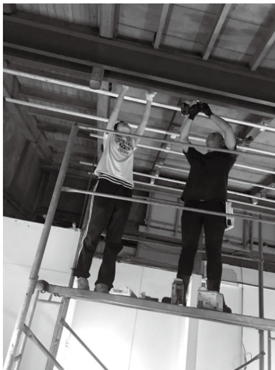
〔図表 12〕 天井の板貼り付けの準備作業
