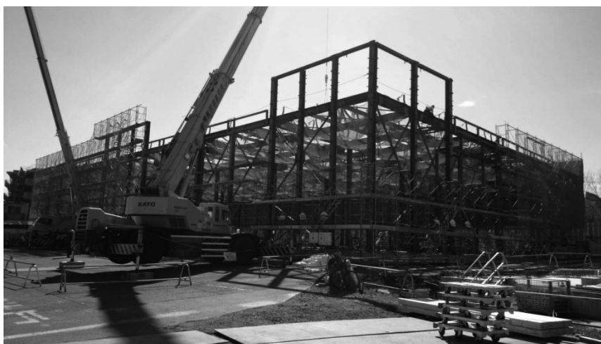
↑ 都内屋内遊戯施設の建築現場
