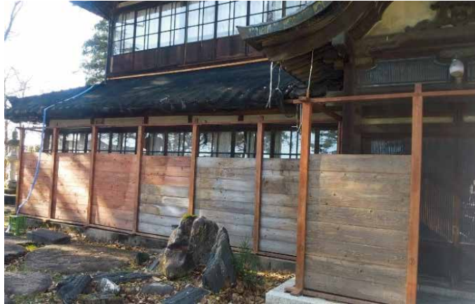
図 3-3-4 離れ座敷の完成した様子
