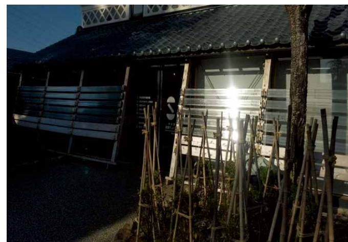
図 3-3-6 米蔵の完成した様子
