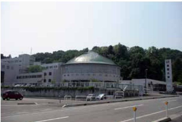
図5 旧体育館棟の外観
