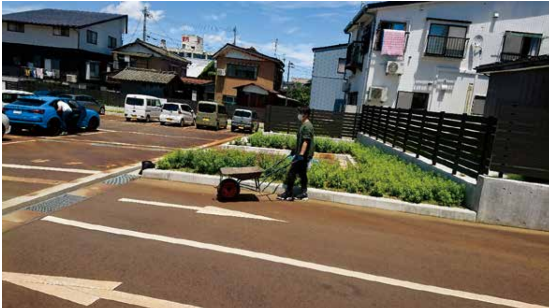
図 2-19 一輪車で運搬作業
