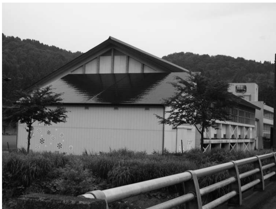
② 安塚中学校の太陽光発電システム
